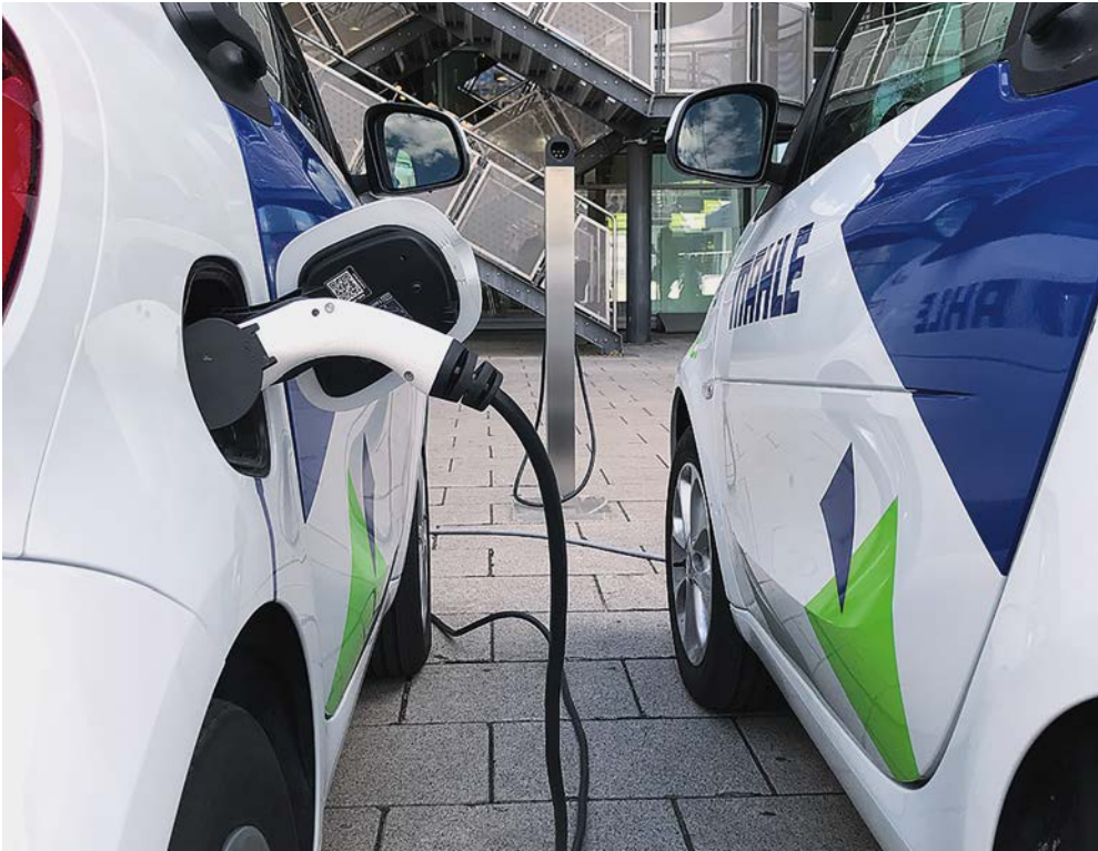
Das MAHLE Corporate Start-up „chargeBIG“ hat ein intelligentes Lademanagementsystem für Dauerparker entwickelt, das sich kostengünstig und ohne langwierige Umbauten in die vorhandene Infrastruktur integrieren lässt.
